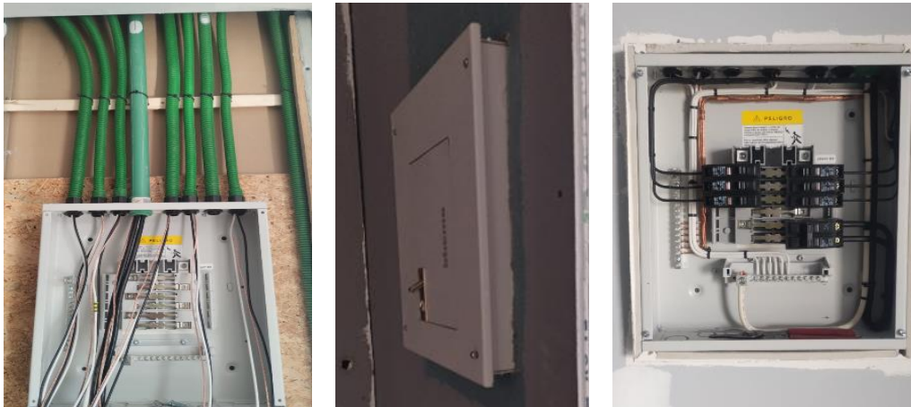
Ilustración 10. Instalación de tableros
