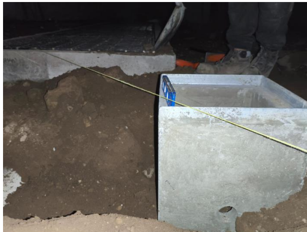
Ilustración 8. Instalación y nivelación adecuada de los registros
