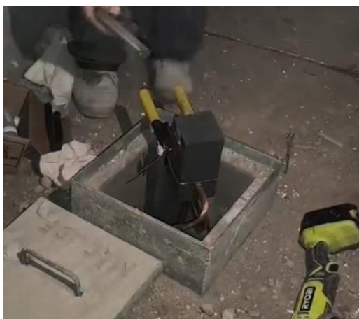
Ilustración 6. Instalación de puesta a tierra
