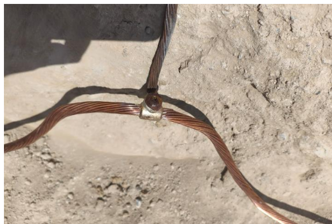
Ilustración 6. Instalación de puesta a tierra
